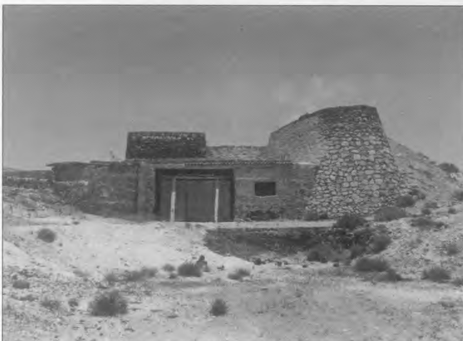
Calera de 4 bocas situada en la montaña de "Chimida" de Teguise.
