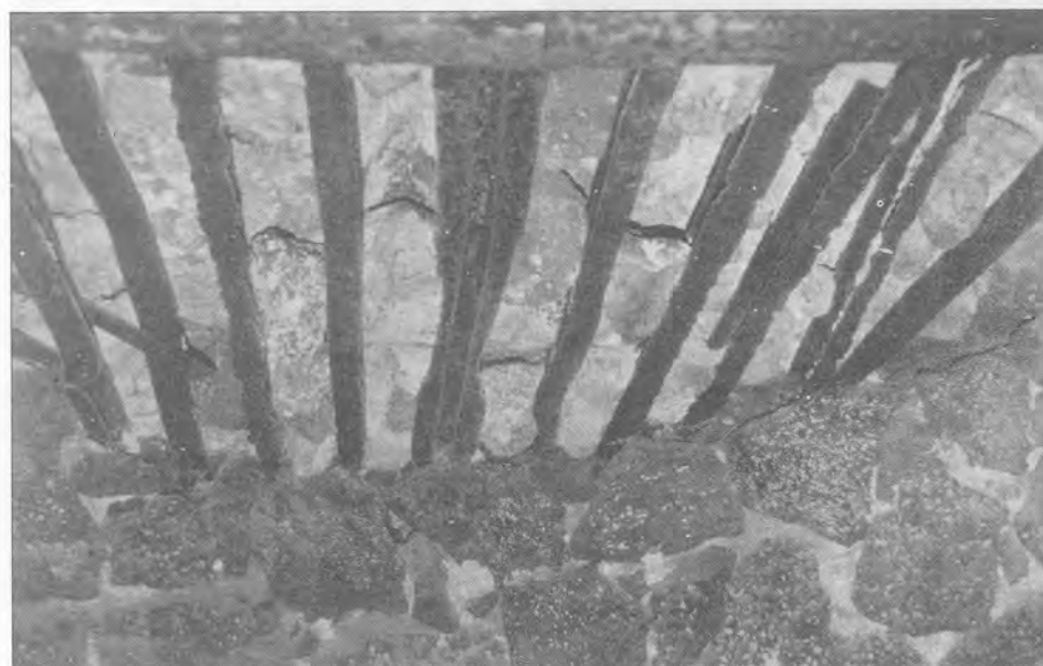
Calera de San Rafael, en Teguisse. Detalle de los raíles que sostenían la cal en el piso del horno.
