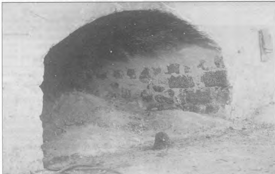
Una de las tres bocas de salida de la Calera de Teguisse, con restos de cal en su interior.
