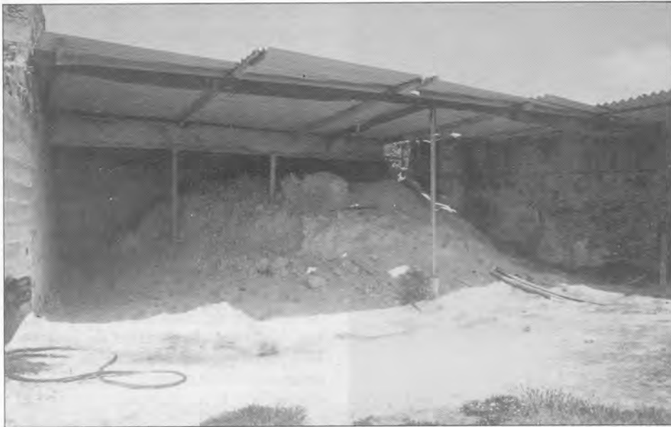
Almacén de depósito de Cal de La Calera de Teguisse.
